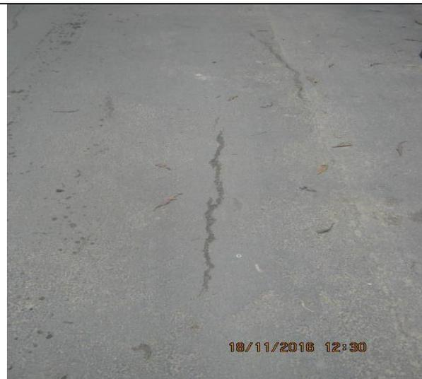
Foto 6. Fisuras Longitudinales al interior de la vía
