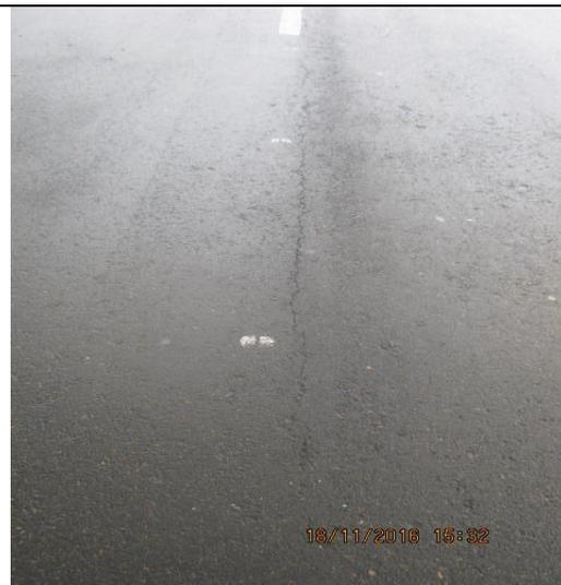
Foto 7. Fisuras Longitudinales al interior de la vía
