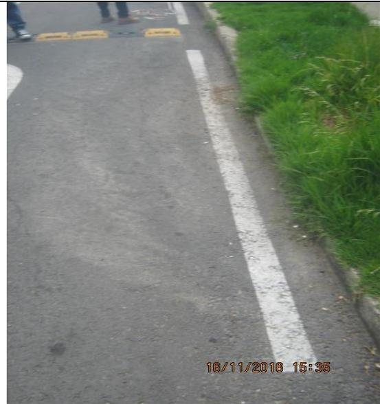
Foto 6. Hundimiento lateral en Calzada aledañas a zona verde
